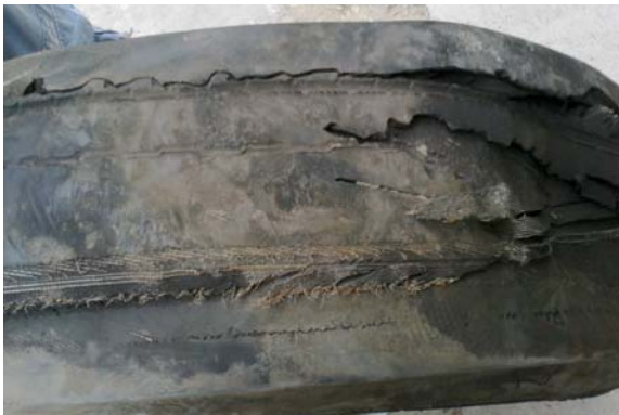
Cubierta colapsada a las 6.00 hs
